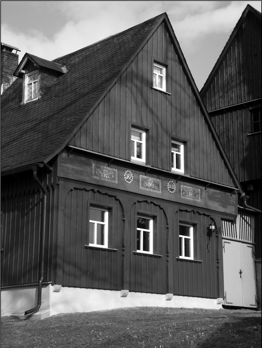
Abb. 6: Raun (Bad-Brambach, Ortsteil Raun) Das ehemalige Wohnstallhaus besitzt eine Blockstube und die dazugehörige Umgebinkonstruktion. Geschätzte Bauzeit ist die zweite Hälfte des 18. Jahrhunderts. Die Remise ist bezeichnet mit der Jahreszahl 1822.
