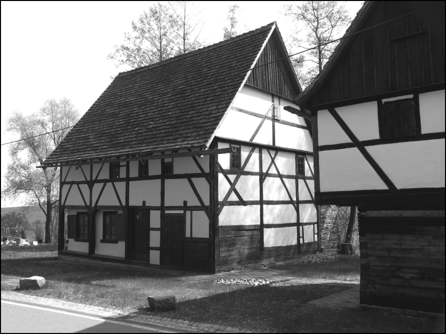
Abb. 7: Franken (Waldenburg, Ortsteil Franken)
